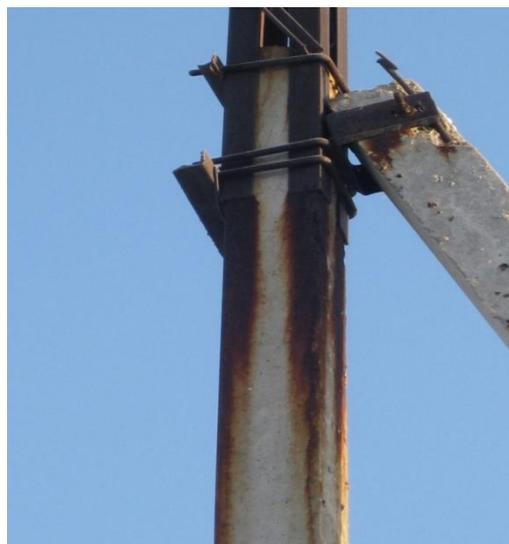
Рисунок 1.10 – Разрушение бетона от токов утечки
