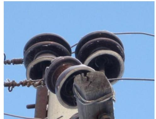
Рисунок 1.9 – Трещина деревянной траверсы
