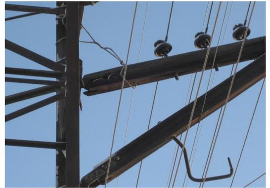
Рисунок 1.7 – Дефект крепления траверсы к опоре
