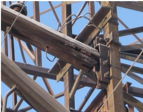
Рисунок 1.8 – Дефект крепления траверсы к опоре
