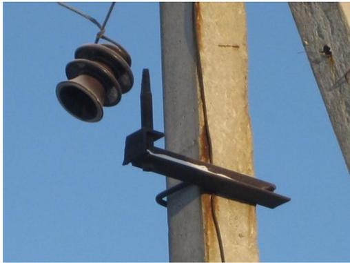
Рисунок 1.6 – Срыв изолятора
